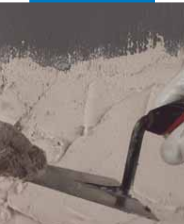
Aufbringen eines Putzes auf Eco Prim Grip
