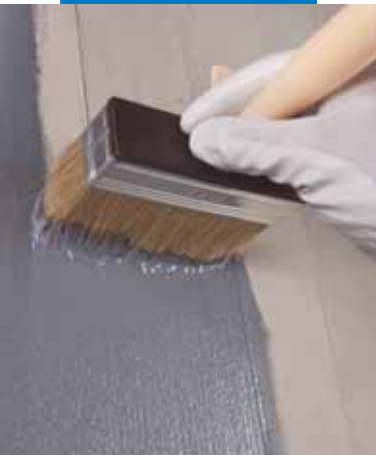
Aufstreichen von Eco Prim Grip auf Beton
