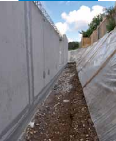
Fugenabdichtung einer erdüberdeckten Wand
