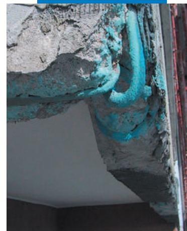
Ferri di armatura del frontalino di un balcone trattati con Mapefer 1K
