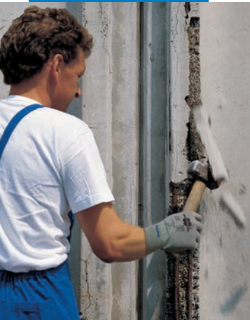
Freilegen der Bewehrungsseisen
