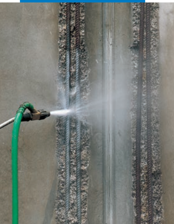
Reinigung der Bewehrungsseisen
