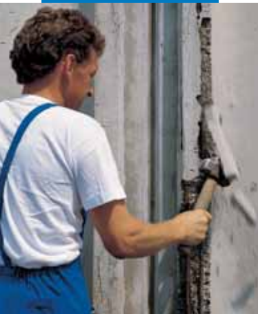
Freilegen der Bewehrungsseisen
