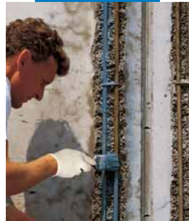
Verarbeitung von Mapefer
