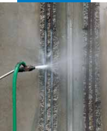
Reinigung der Bewehrungsseisen
