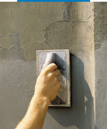
Glätten mittels Glättkelle
