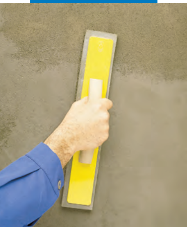
Glätten mittels Schwammbrett
