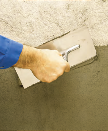
Verarbeitung im Spachtelverfahren
