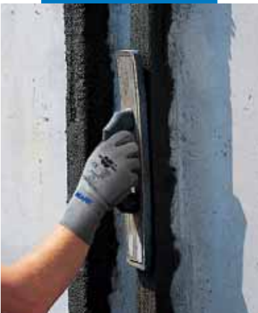
Nachbehandlung des Mapegrout-Mörtels
