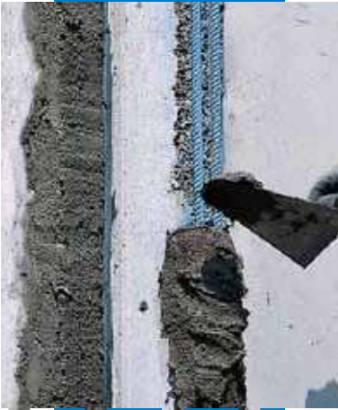
Aufbringen von Mapegrout Tissotropico
