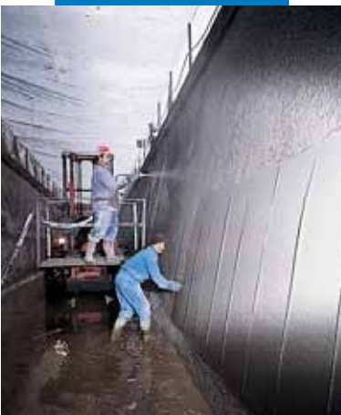
Glätten der frischen spritzrauh Oberfläche im Kanal Bertini - Robbiate (Como) - Italien
