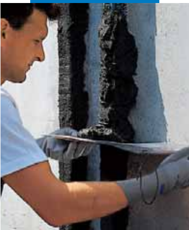
Abziehen von Mapegrout-Mörtel mit einer Schablone
