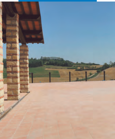
Fliesenverlegung mit Granirapid auf Mapelasticüü
