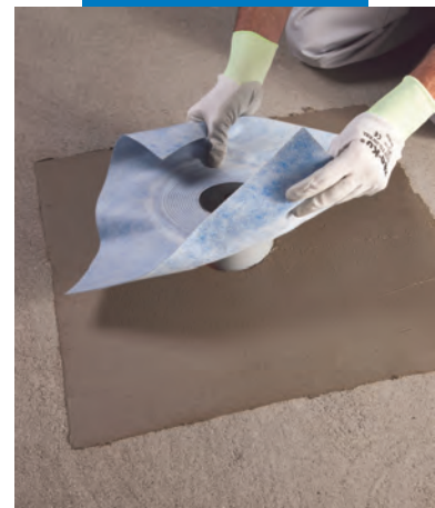
Abdichtung eines Schwimmbeckens mit Mapelastic
