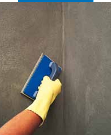
Finishbehandlung mit einem Schwambrett
