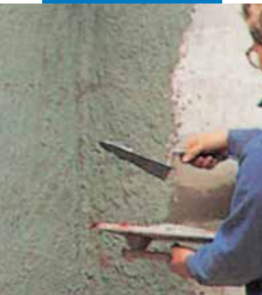
Mit Planicrete vergüteter Haftputz
