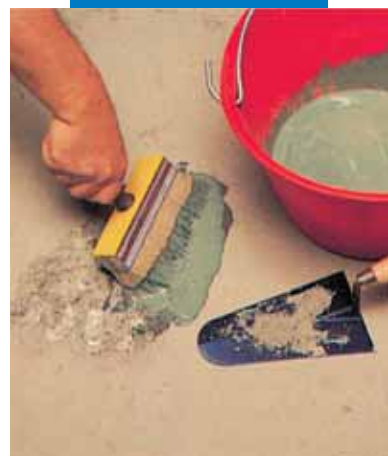
Partielle Reparatur: Aufbringen der Haftschlämme
