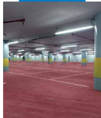
Berlaymont Building, Brüssel - Belgien Ultratop rot
