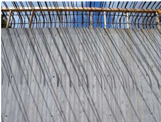
Brückenwiderlager mit Brettschalung
