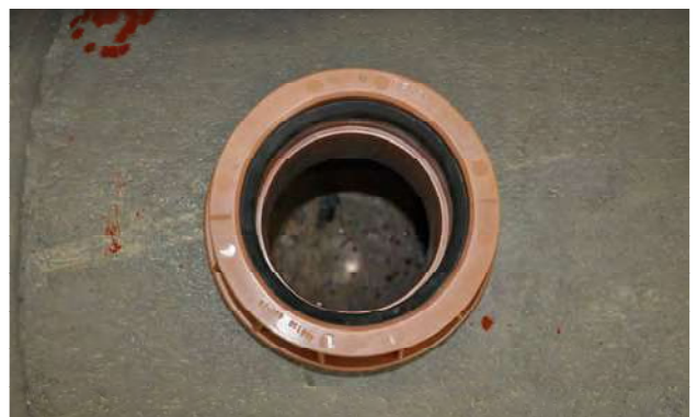
Bild 13: Keilgleitdichtung und Spitzende mit Gleitmittel einschmieren
