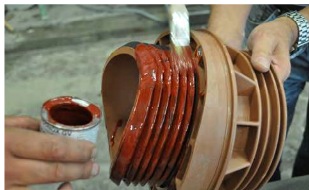
Bild 9: Auftragen von DENSONOX GV auf Dichtungsmanschette
