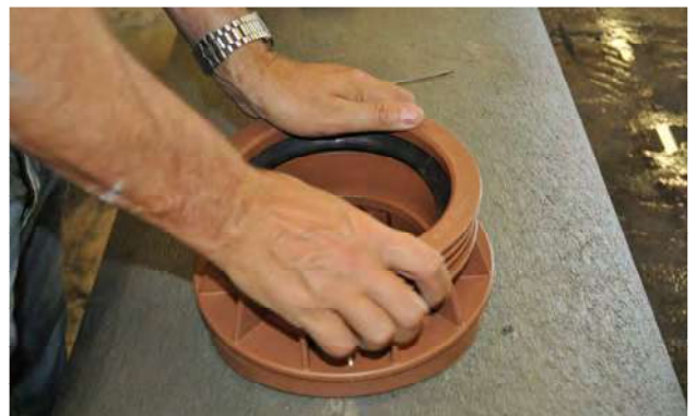
Bild 12: Steckanschlussstück einpressen
