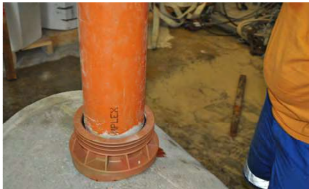
Bild 14: Anschlussrohr anschliessen
