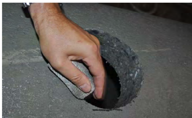
Bild 7: Bohrlochkante abrunden und Bohrloch reinigen
