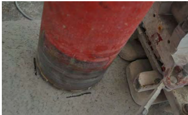
Bild 6: Korrekt montiertes Kernbohrgerät
