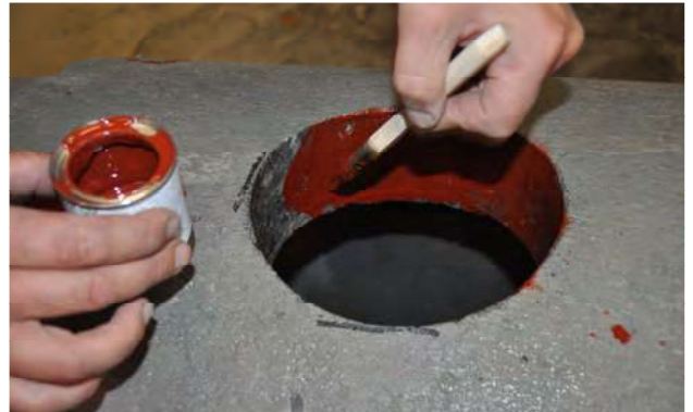
Bild 10: Auftragen von DENSONOX GV auf Bohrlochwandung
