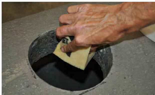
Bild 8: Bohrlochwandung mit Wasser befeuchten
