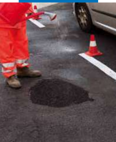
Wässerung der Oberfläche
