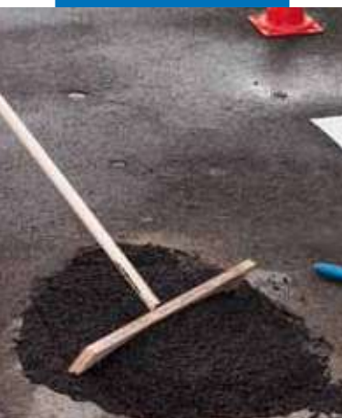
Einbringen und Verarbeiten von Mape-Asphalt Repair 0/8
