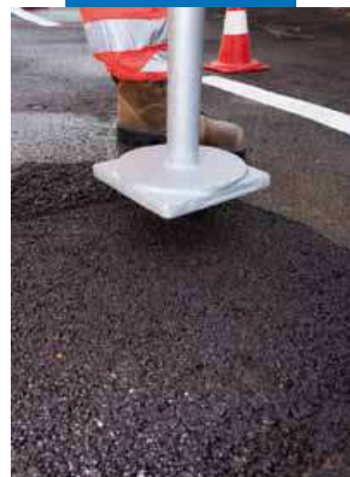
Manuelle Verdichtung
