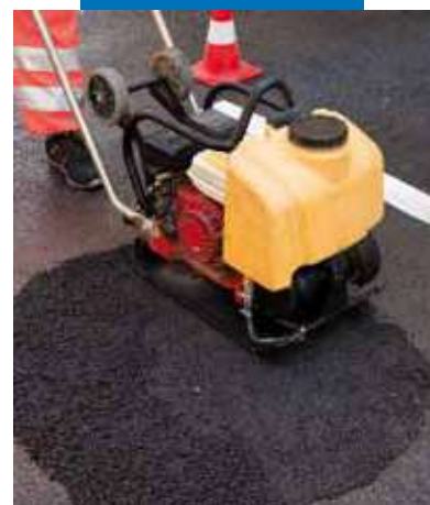
Maschinelle Verdichtung
