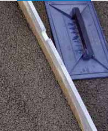
Abziehen des Mapedrain Monokorn-Estrichs
