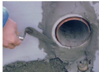
Schachtfutter einmörteln mit PCI Polyfix plus.
