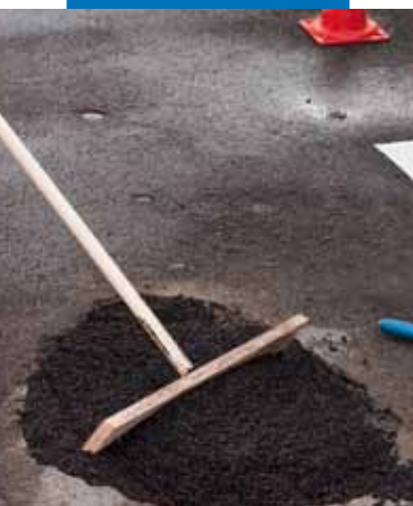
Einbringen und Verarbeiten von Mape-Asphalt Repair 0/8
