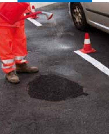
Wässerung der Oberfläche
