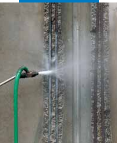
Reinigung der Bewehrungsseisen
