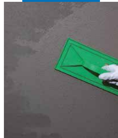
Abreiben der mit Mapegrout 430 reprofilierten Fläche
