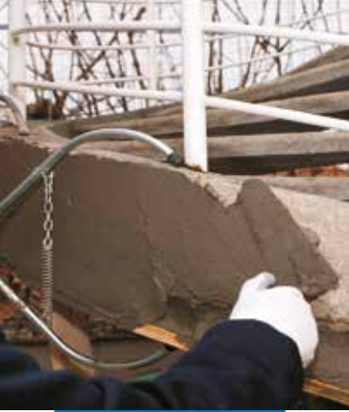
Auftragen von Mapegrout 430 mit einer Kelle
