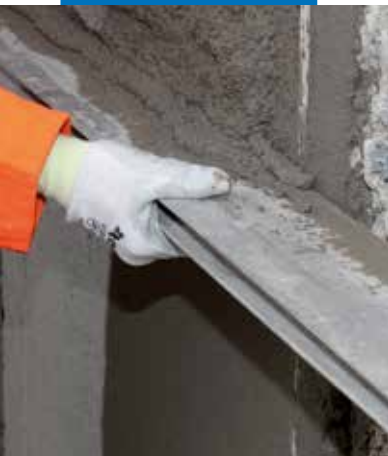
Abziehen von Mapegrout 430 mit einer Latte
