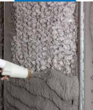
Auftragen von Mapegrout 430 im Nassspritzverfahren
