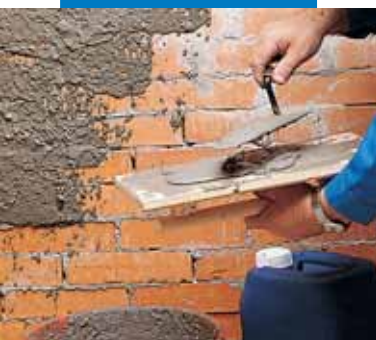
Auftragen eines mit Planicrete modifizierten Spritzbewurfs
