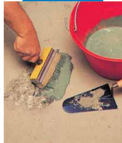
Partielle Reparatur: Aufbringen der Haftschlämme
