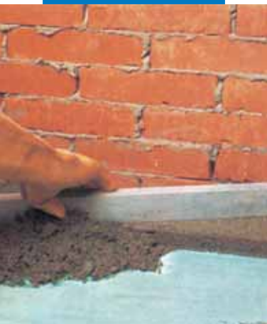
Auftragen eines mit Planicrete vergüteten Zementestrichs
