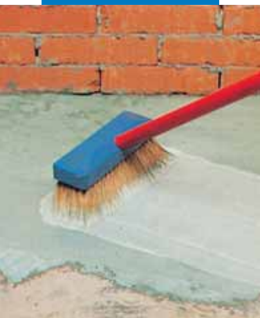
Auftragen einer mit Planicrete vergütetem Zementhaftschlämme
