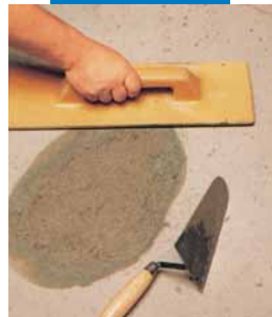
Partielle Reparatur: Abglätten der frischen Flickstellen
