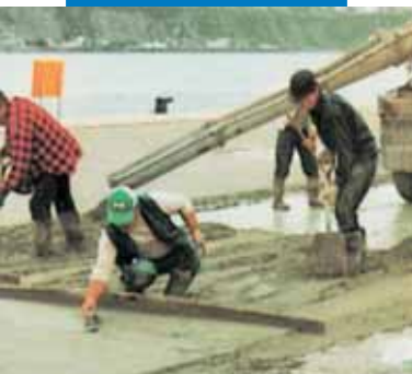
Einbau eines mit Planicrete vergüteten Estrichs im Außenbereich - Vieux Port, Quebec, Kanada
